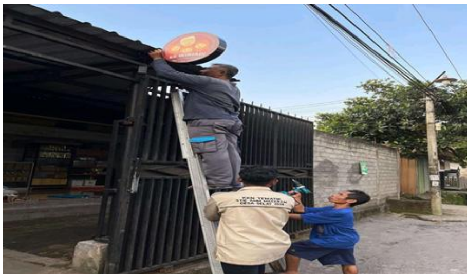
Gambar 1. Proses pembuatan dan pemasangan plang nama usaha UMKM Dodol Ibu Eli
